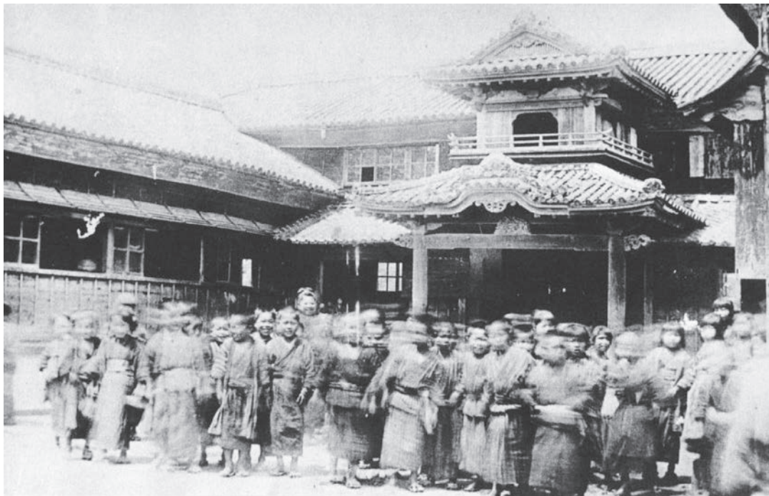
（新築された木本小学校校舎）とても立派な校舎で代官所跡に建てられました
