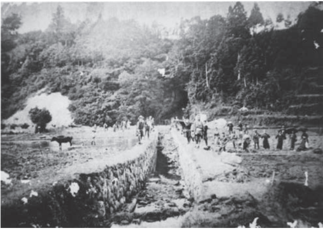
(工事の様子) 要害山はまだ削られていなかった
