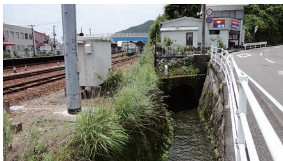
（要害山の下にトンネルを掘った）
